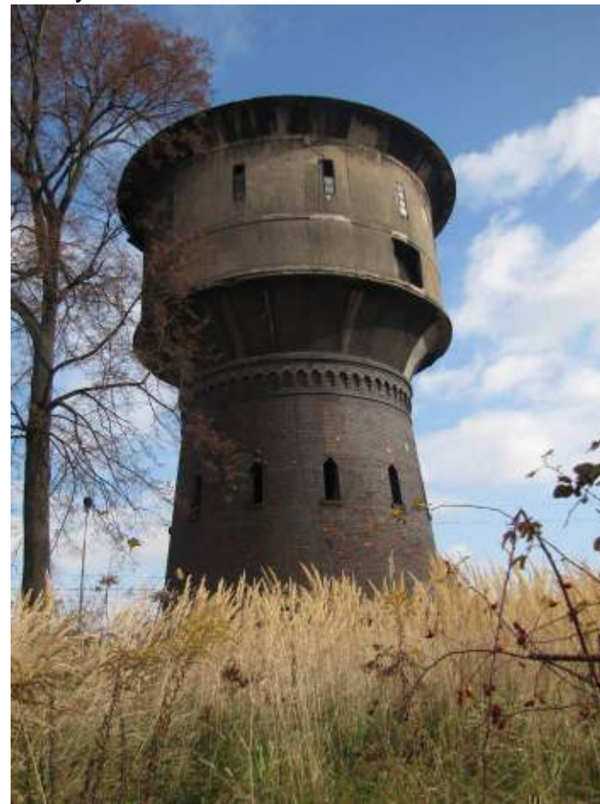
Fot. Wieża Ciśnień
